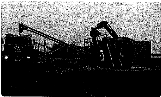
Рис. 2. Грунтосмесительная установка непрерывного действия на строительной площадке аэродрома «Сабетта»
