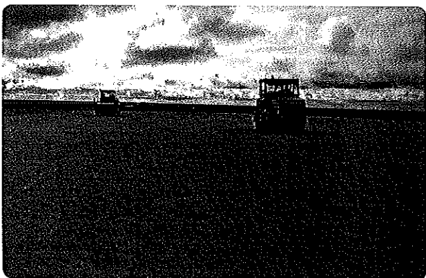
Рис. 3. Уплотнение искусственного основания аэродромной одежды из укрепленного песка катками на пневмоколесном ходу
